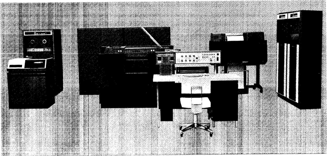
Figure 26. Disk-Storage-Oriented 1460 System
